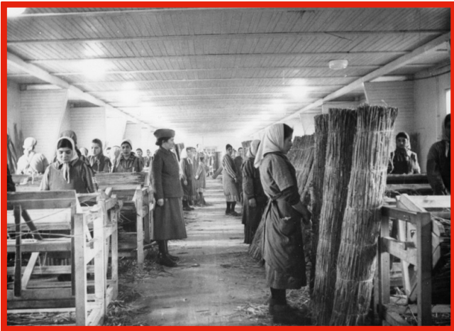
Prisioneros romani realizan trabajos forzados en el campo de concentración de Ravensbrueck. Alemania, entre 1941 y 1944.
